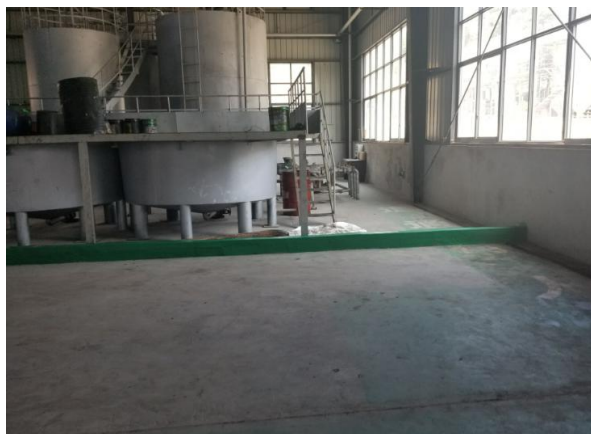
生产罐区围堰
