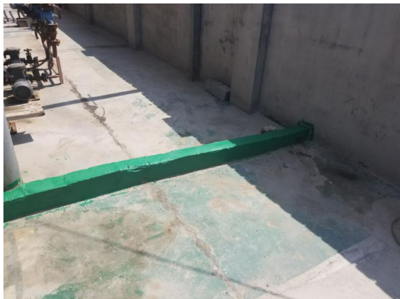
生产罐区围堰
