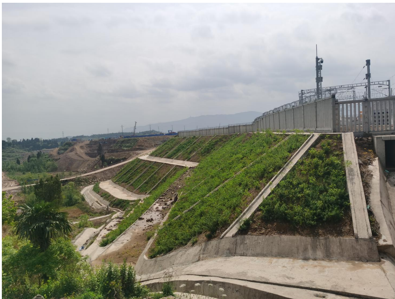
线路工程现状
