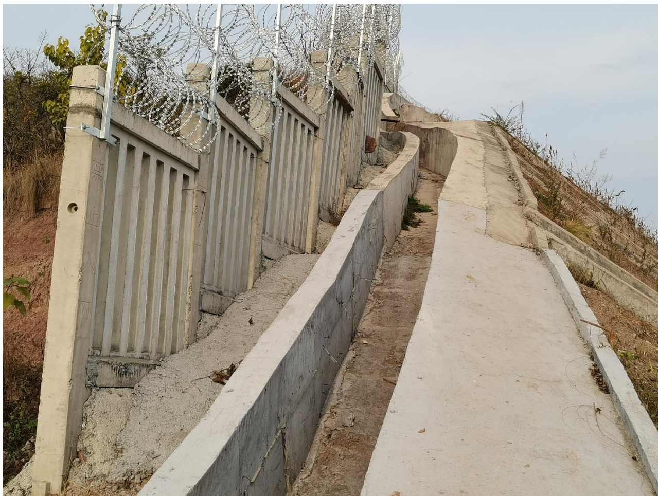
截排水沟现状
