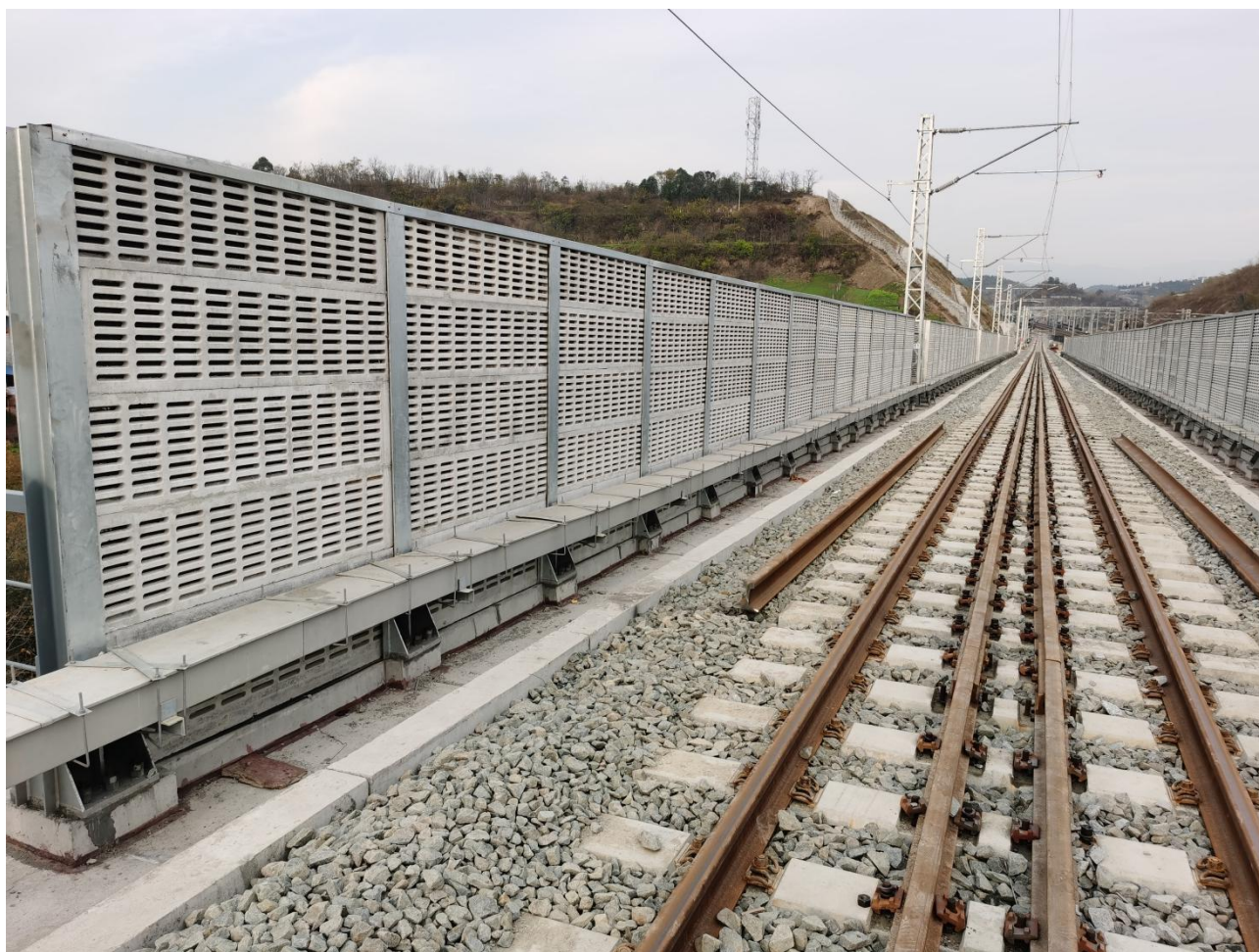
线路工程现状
