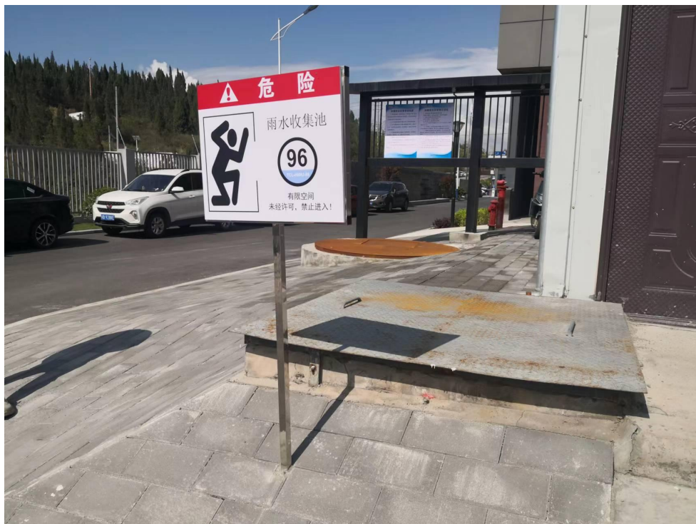
初期雨水收集池
