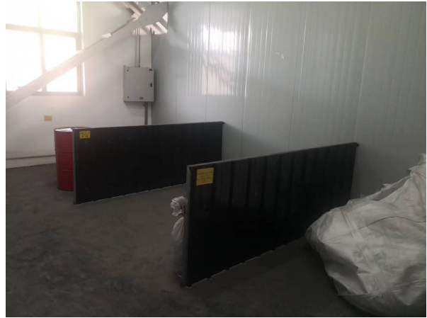
危废暂存间分区
