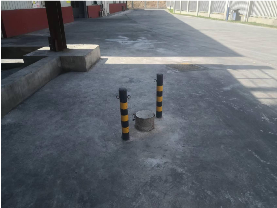
地下水监测井
