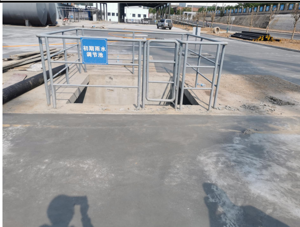
依托的林丰铝电已建初期雨水收集池
