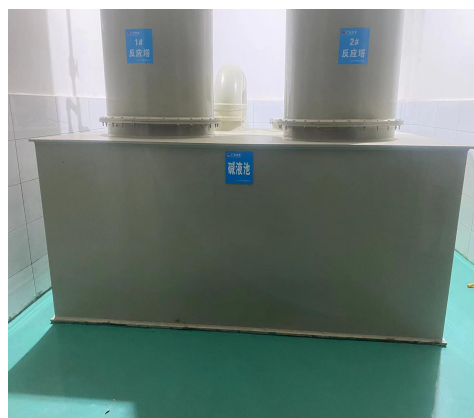
氯气回收间 重点防渗地面
