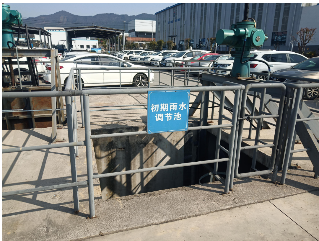
图2-6 初期雨水收集池
