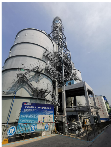
电解烟气脱硫净化系统及其排气筒
