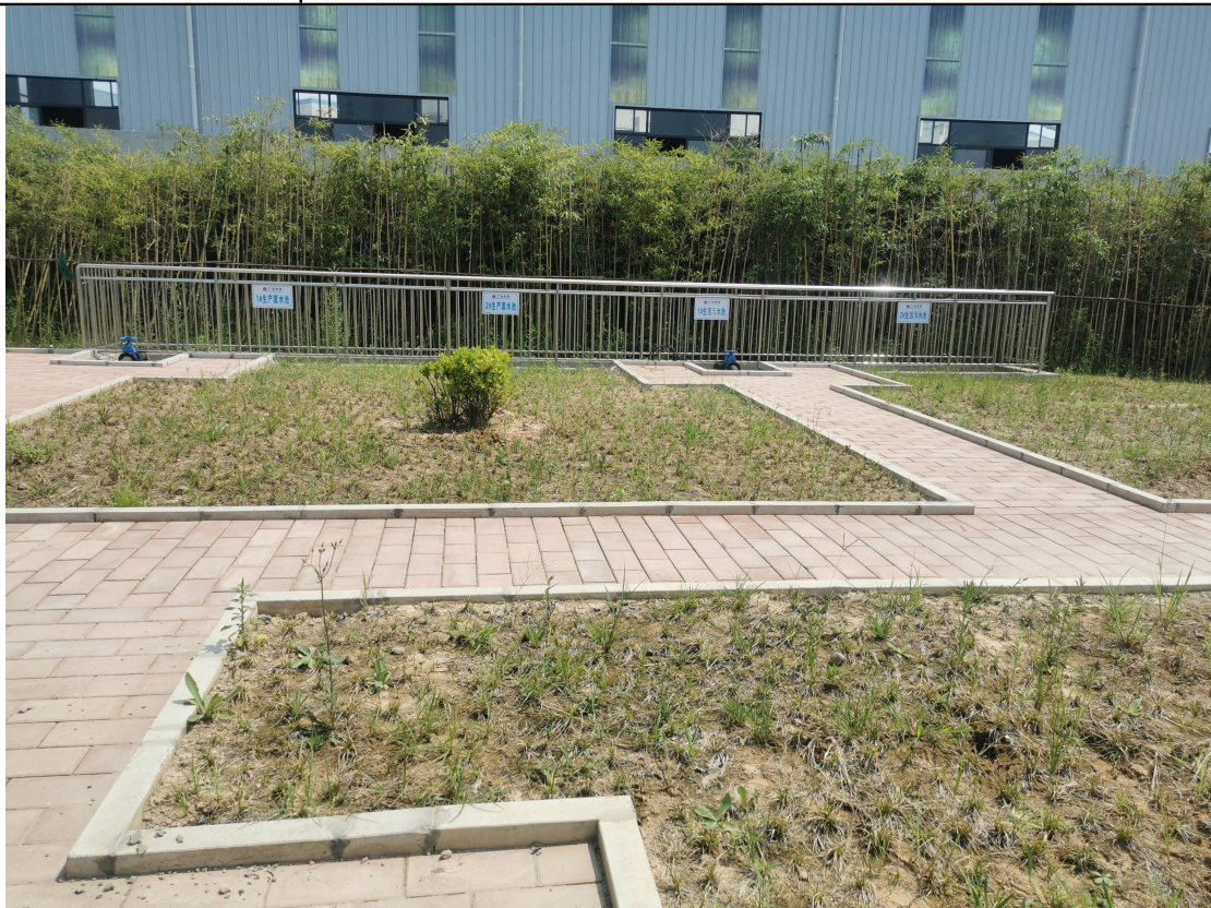
图 2-4 生产废水收集池、生活污水收集池
