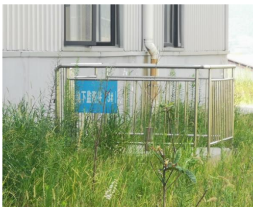
3#: 抬包清理车间西侧、废暂存间东南侧
