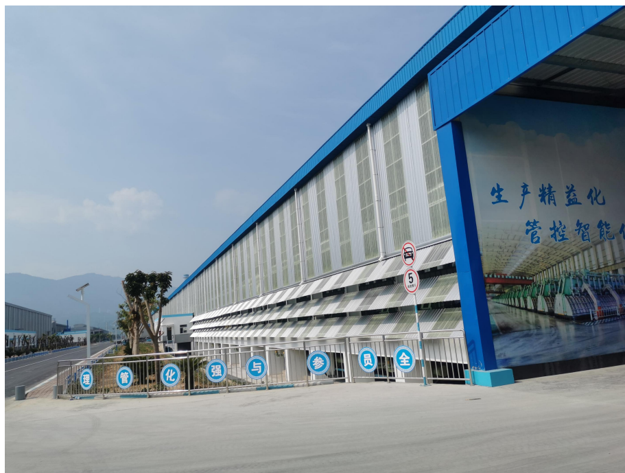
电解车间（外部）
