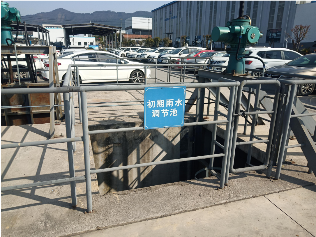
初期雨水收集池
