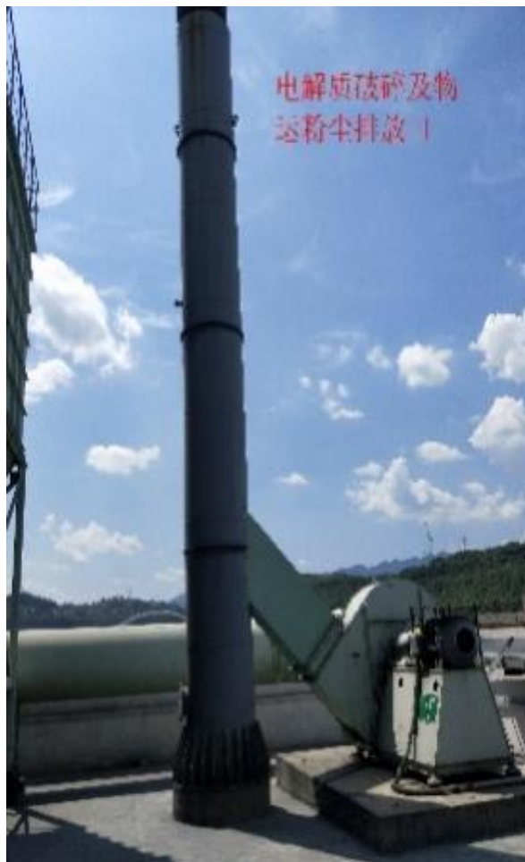
电解质反击破碎、筛分及物料输送、电解质料仓粉尘除尘器及其排气筒
