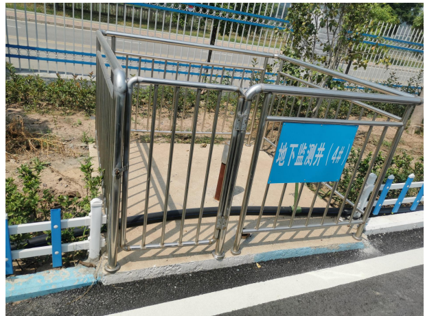
4#: 厂界内地下水下游方向、废水收集池西侧
