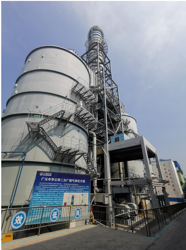
电解烟气脱硫净化系统及其排气筒
