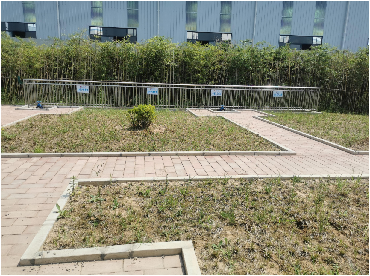
生产废水收集池、生活污水收集池
