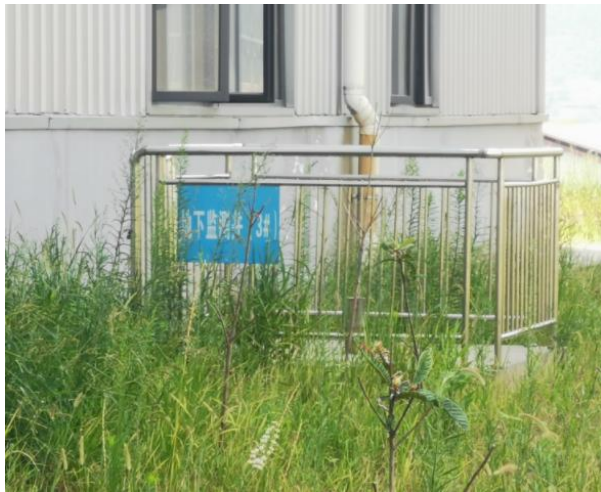
3#: 抬包清理车间西侧、废暂存间东南侧
