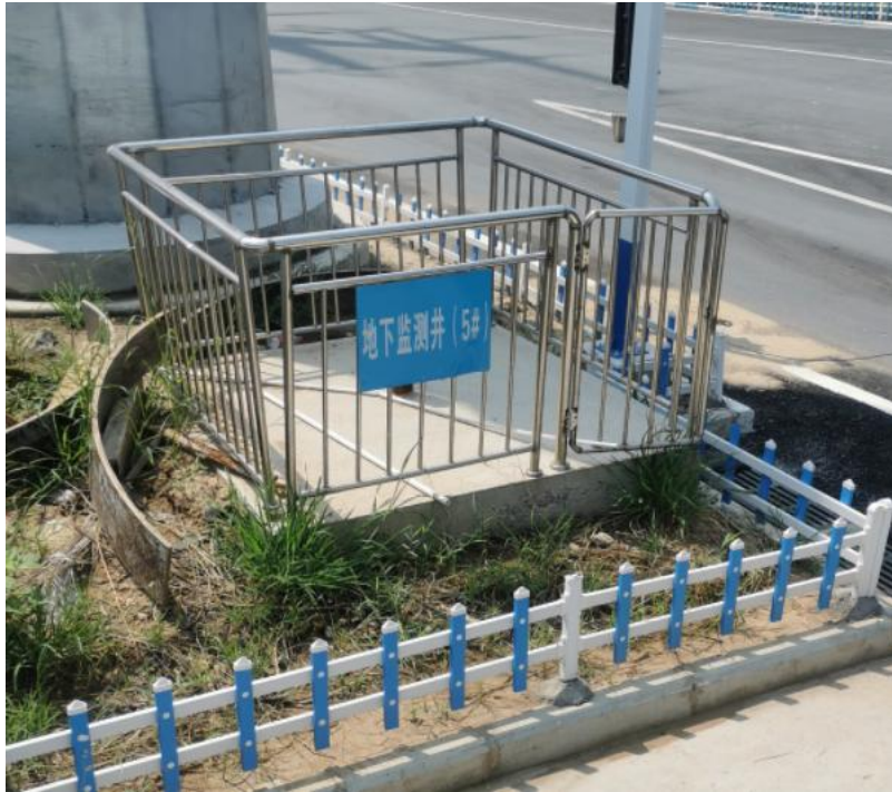
5# 场内初期雨水收集池旁
