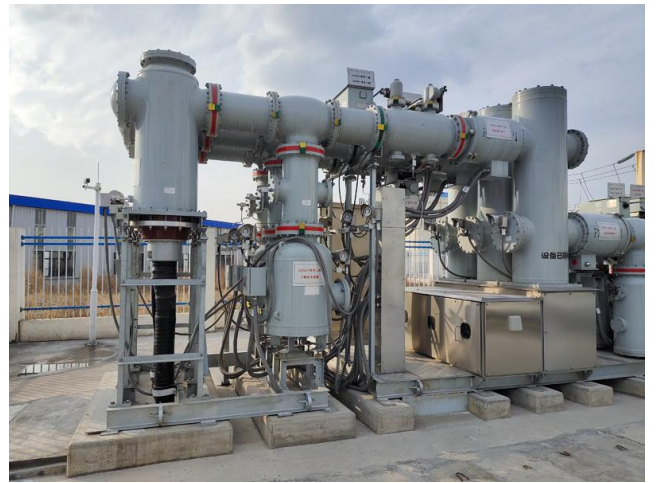
220 kV 开关站（户外 GIS 布置）
