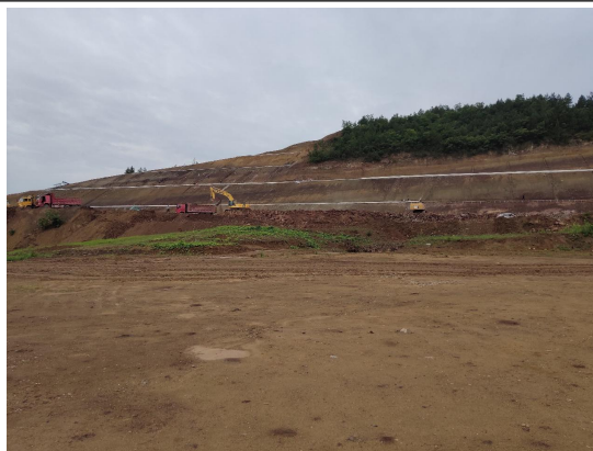
线路工程土石开挖
