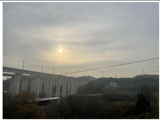
桥梁工程现状
