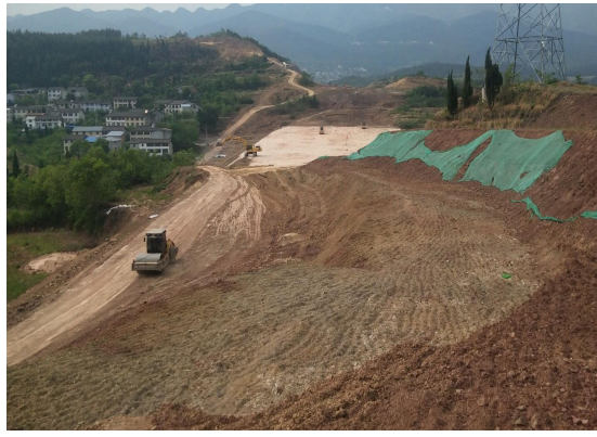
存车场施工过程中
