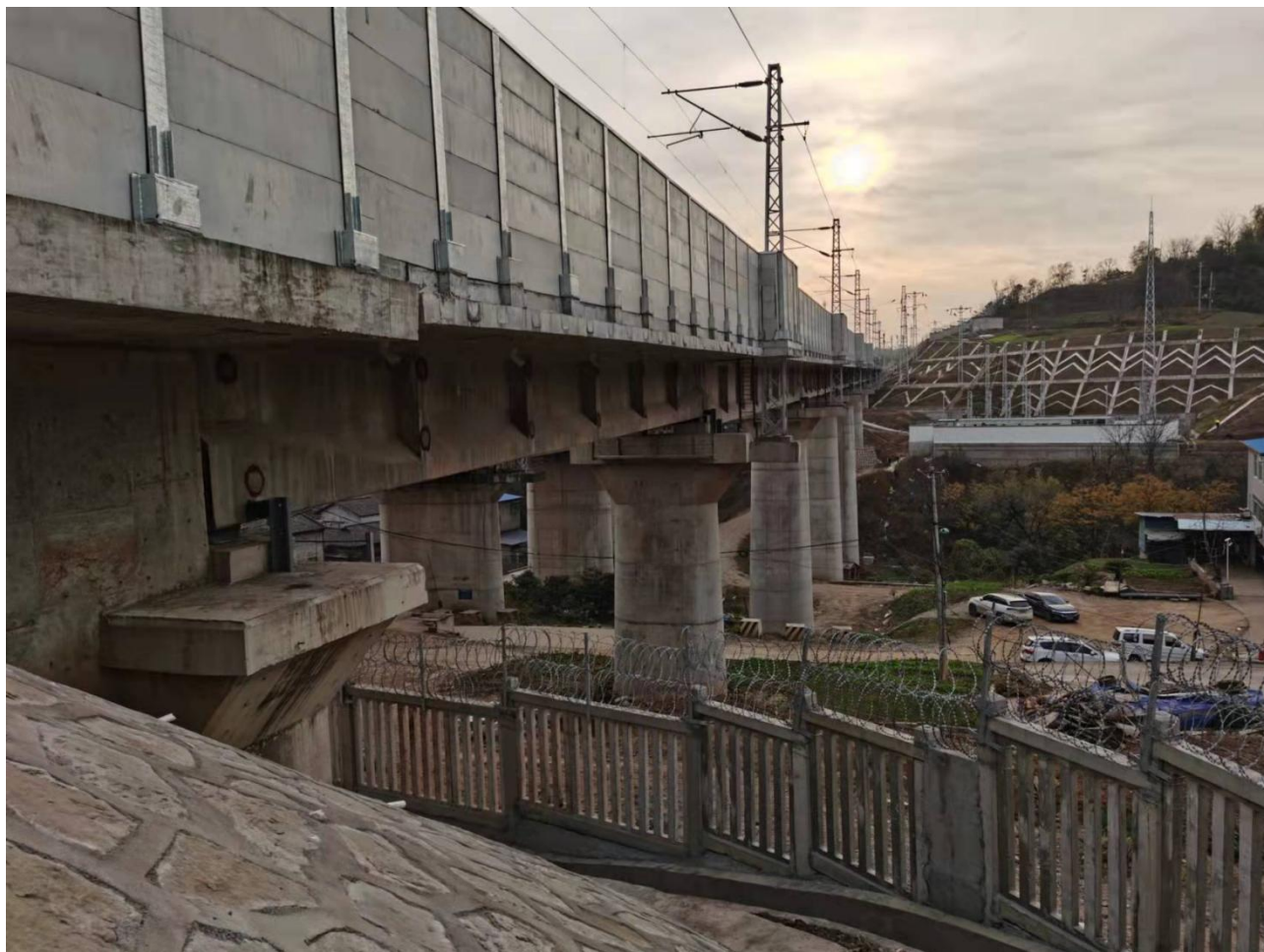
线路工程现状
