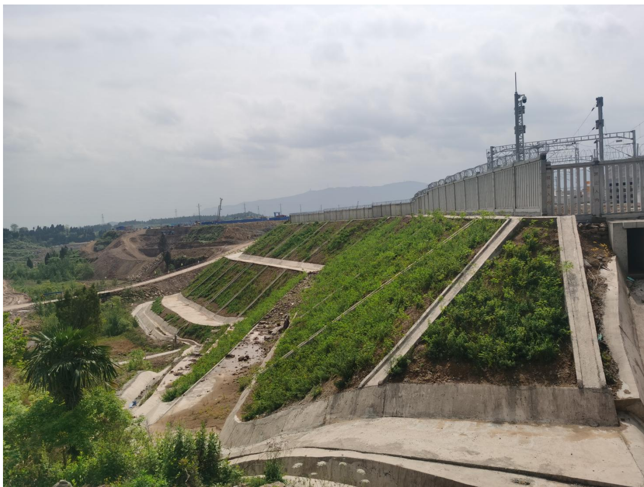
线路工程现状
