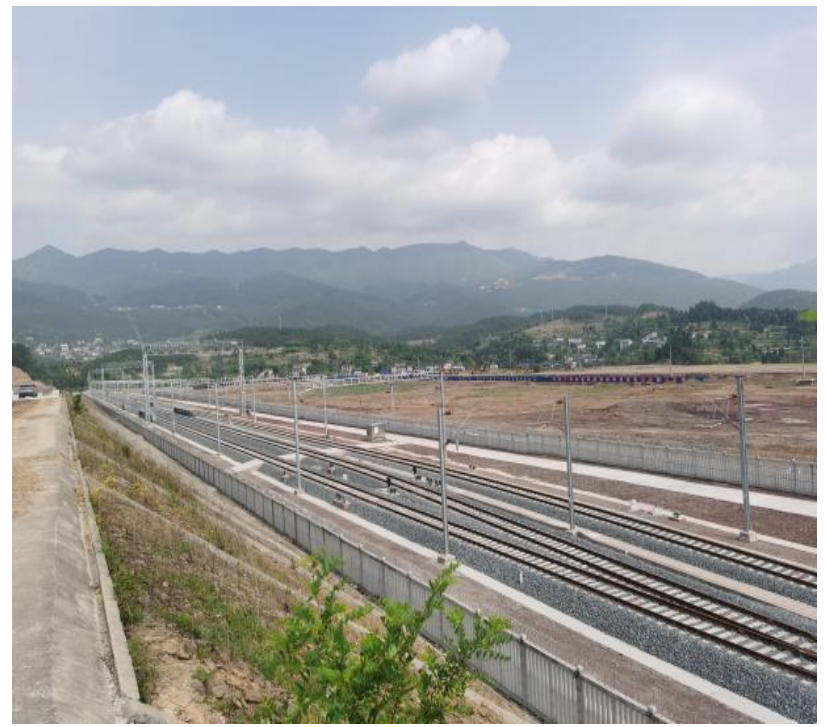
施工后存车场
