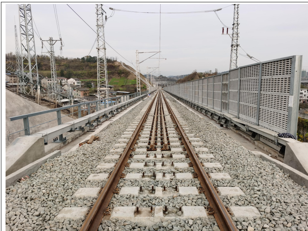
施工后线路工程
