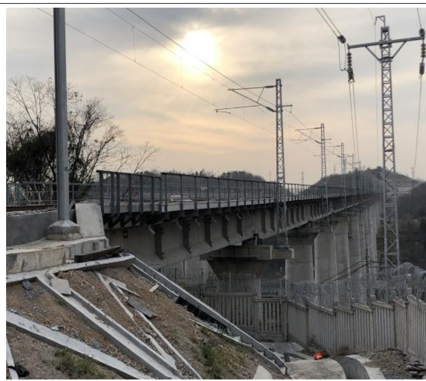
施工后桥梁工程
