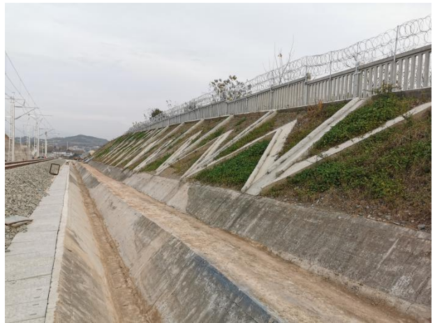
动车走行线两侧护坡、截排水沟
