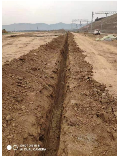
污水管网敷设照片
