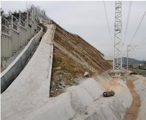
动车走行线两侧护坡、截排水沟
